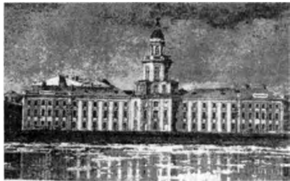
8. Здание музея. Вид со стороны Невы
