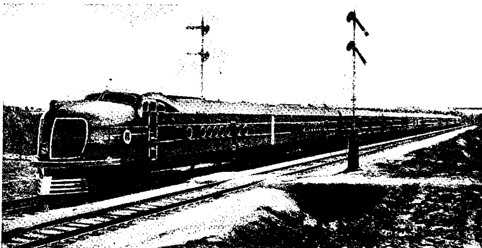
Современный скоростной поезд. Сделан в основном из легких алюминевых сплавов.
