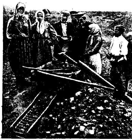
Проба на содержание золота промывкой песка в лотке.
