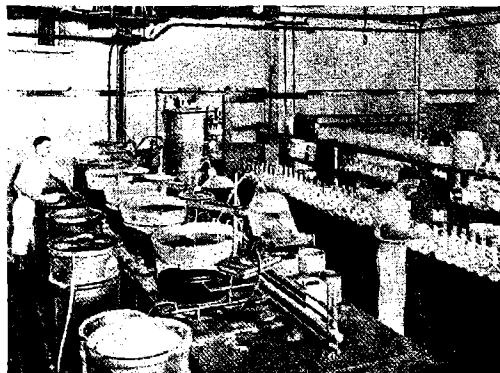
Многokратная кристаллизация растворов для разделения редких земель в одной из современных лабораторий.
